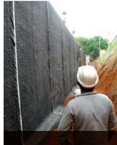
Drenaggio di un rilevato ferroviario
