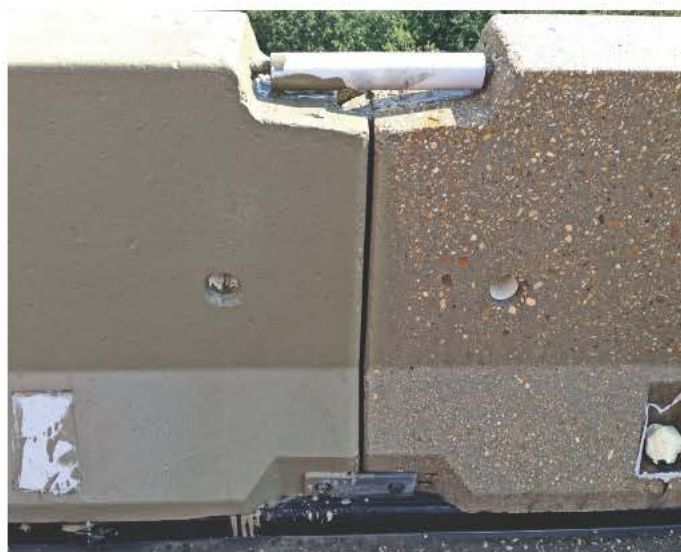
3. L'applicazione di Penetron Standard su barriera New Jersey: il trattamento consente di aumentare la durabilità del manufatto specialmente in ottica di resistenza ai cicli gelo-disgelo e all'azione di degrado dei sali disgelanti
