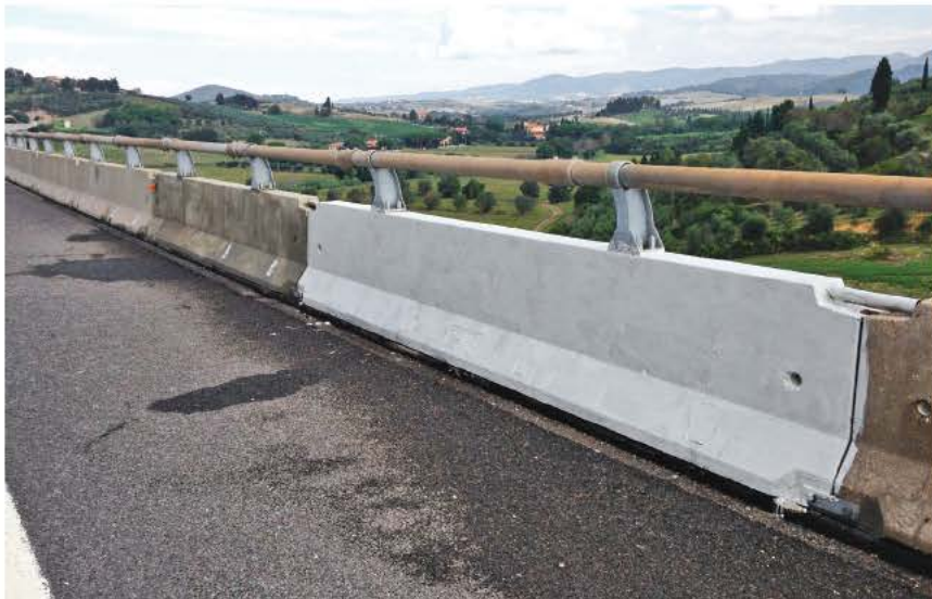
6. Un New Jersey in cui si vede il trattamento esteso con boiaccia Penetron standard sia grigia che bianca
