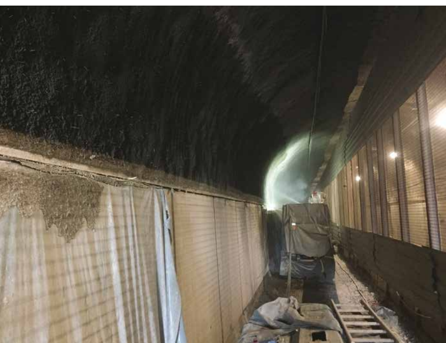
1. Vista di parte della volta in spritz-beton impermeabile
